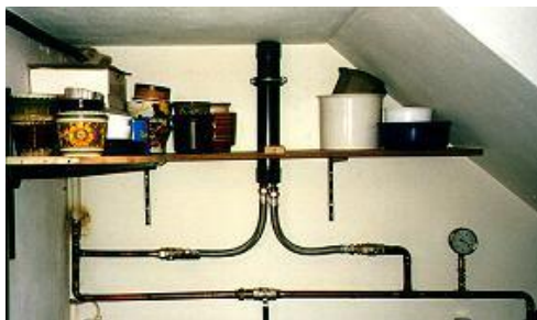
Montage nach der Wasseruhr
