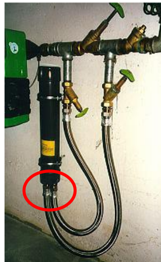
El activador instalado por debajo del conducto de Agua, con las conexiones hacia abajo
